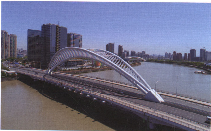
宁波市长丰桥及接线工程
